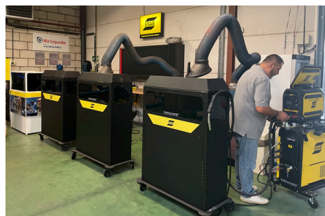
Préparation de l'atelier de soudage
